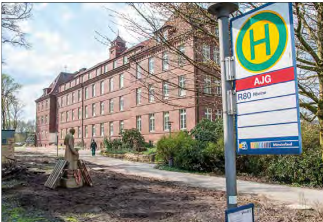
Namensgeber Arnold Janssen hat an seinem neuen Platz die Abrissarbeiten gut im Blick.
